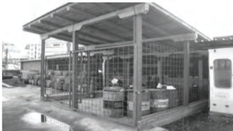
Слика 53. Надстрешница за складиштење буради са отпадним уљем и филтерима
