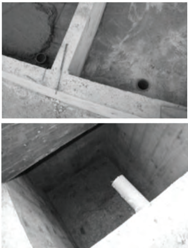
Слика 60. Сливици за одвођење просутог уља
