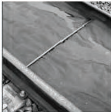
Слика 13. Пример заштитног подметача за апсорпцију евентуално просутог уља причвршћеног за шине
